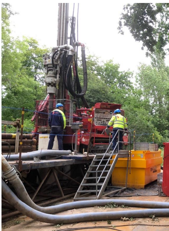
Figuur 22-1 Voorbeeld van een verhoogd opgestelde opstelling van de boorinstallatie en de mantelbuis.
