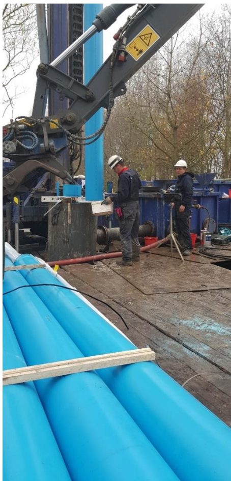
Foto 23-1 Lijmen spie-eind en mof (foto Vitens).
