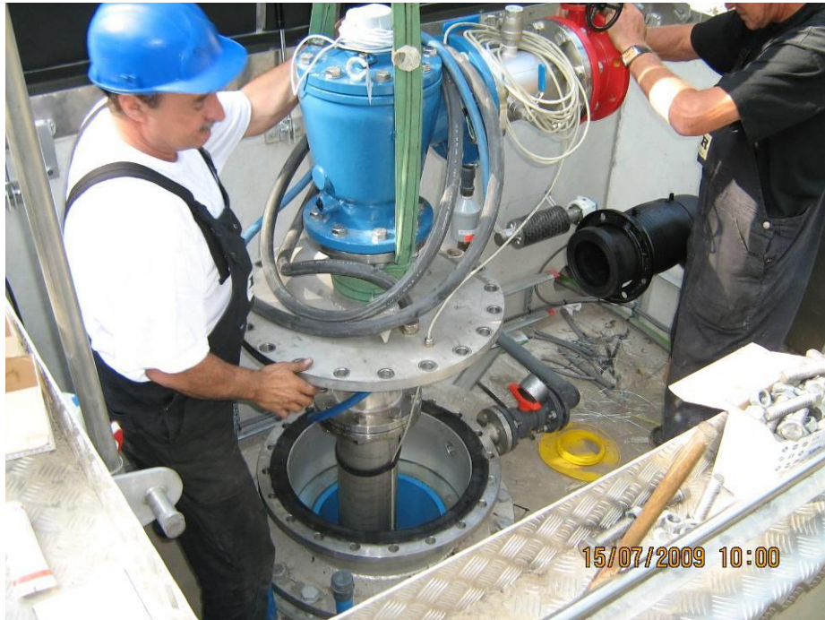
Foto 23-1 Het installeren van een pomp, haalbuizen en watermeter (foto Brabant Water).
